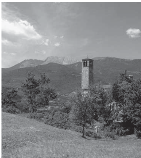
Vista del cinquecentesco campanile della Chiesa dell'Eremo.
